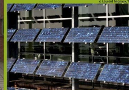
Panneaux photovoltaïques utilisés en pare-soleil.
