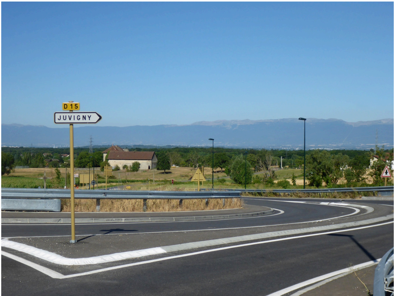
Vue vers l'Ouest sur le château de Neydens depuis le pont franchissant la RD 1206 (2015)
