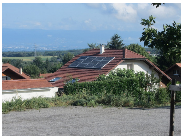
Panneaux solaires sur une toiture à Saint-Cergues
