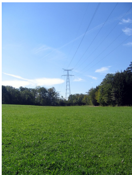
Ligne à haute tension
