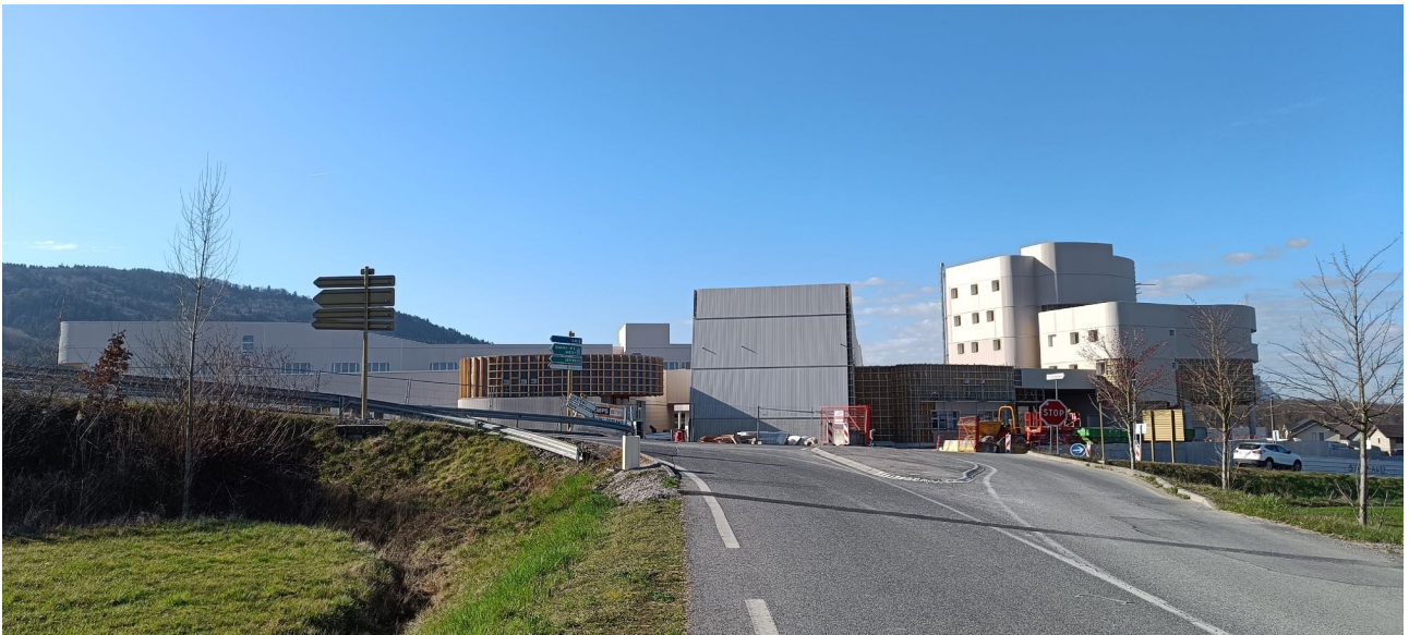
Collège en cours de construction au 20/03/2025
