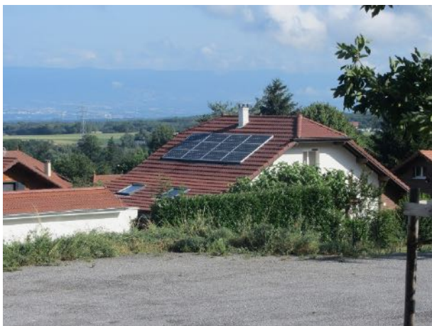
Panneaux solaires sur une toiture à Saint-Cergues
