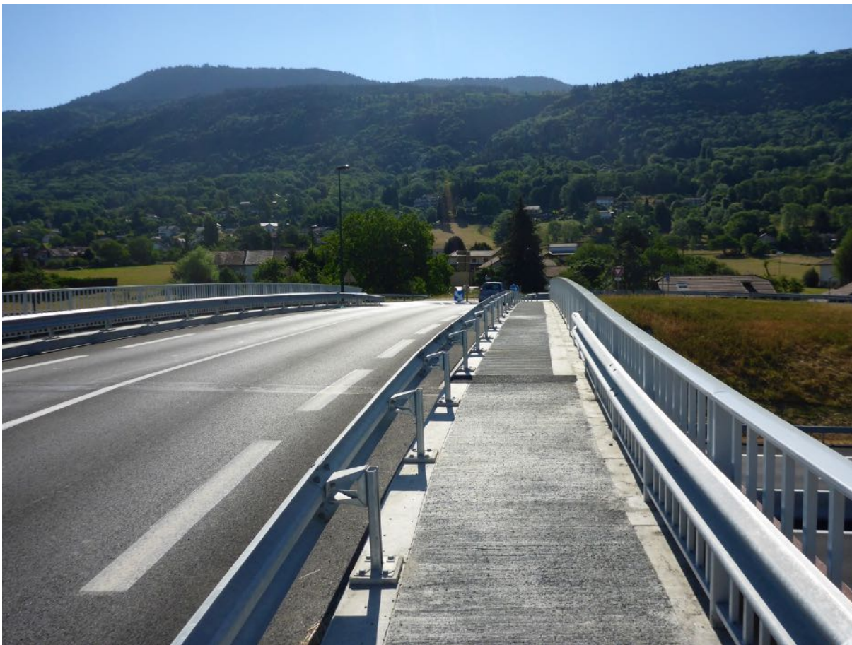
Le franchissement de la RD 1206 : un compromis équitable entre voitures et piétons ? (20/03/2025)
