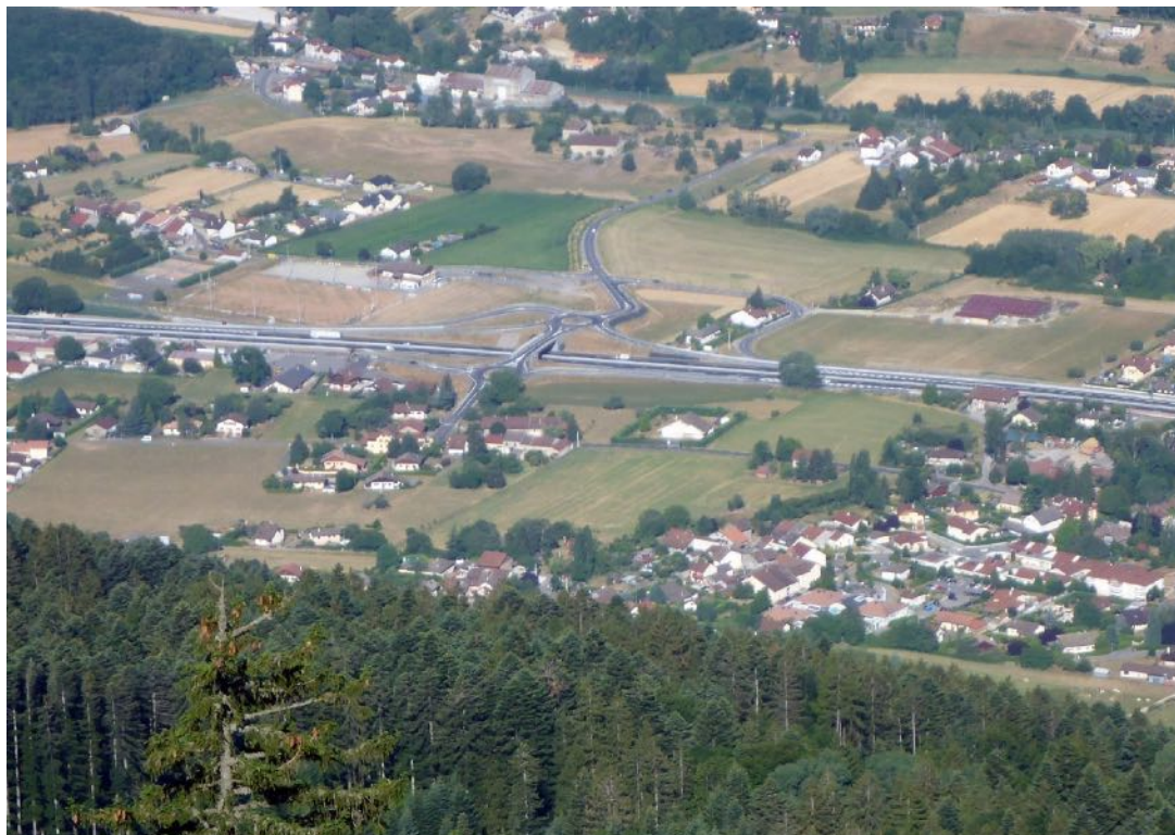
Vue depuis la crête des Voiron, une structure urbaine difficile à déchiffrer.
