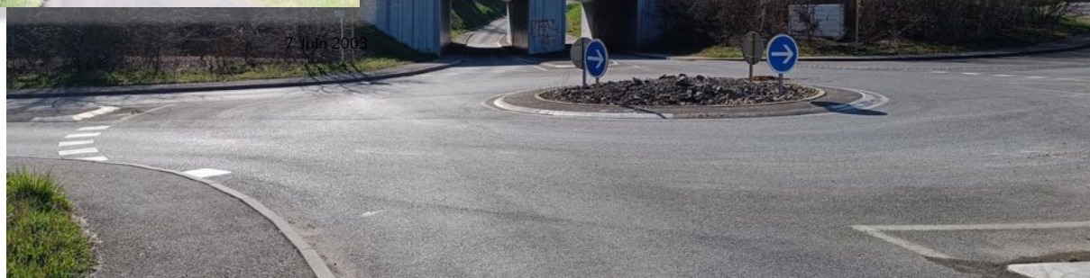
Vue sur le doublement du passage inférieur (20/03/2025).
