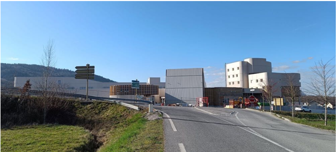
Collège en cours de construction au 20/03/2025
